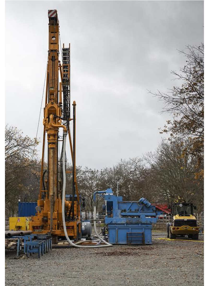
Bohranlage für Geothermie, © Stadt Frankfurt am Main, Foto: Hannes P. Albert
